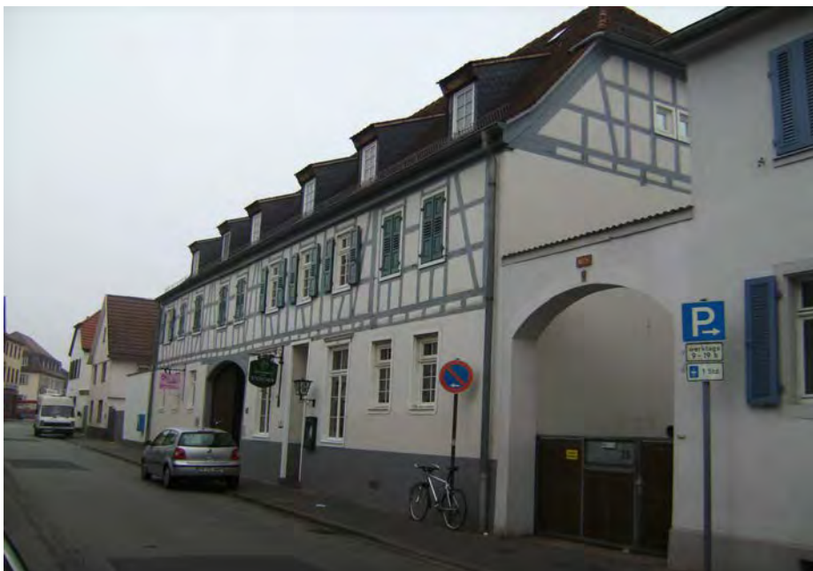
Gasthaus „Zum Storchen“ nach der Renovierung 38)
