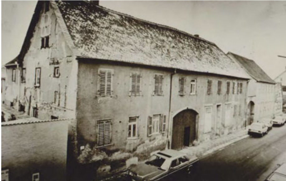
Noch nicht renovierte Gasthaus „Zum Storchen“ 37)
