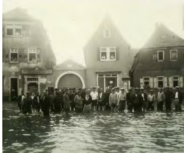
Überschwemmung von 1932 - Blick von der Darmstädter Straße auf das ehemalige Gasthaus „Zum weißen Roß“ 51)
