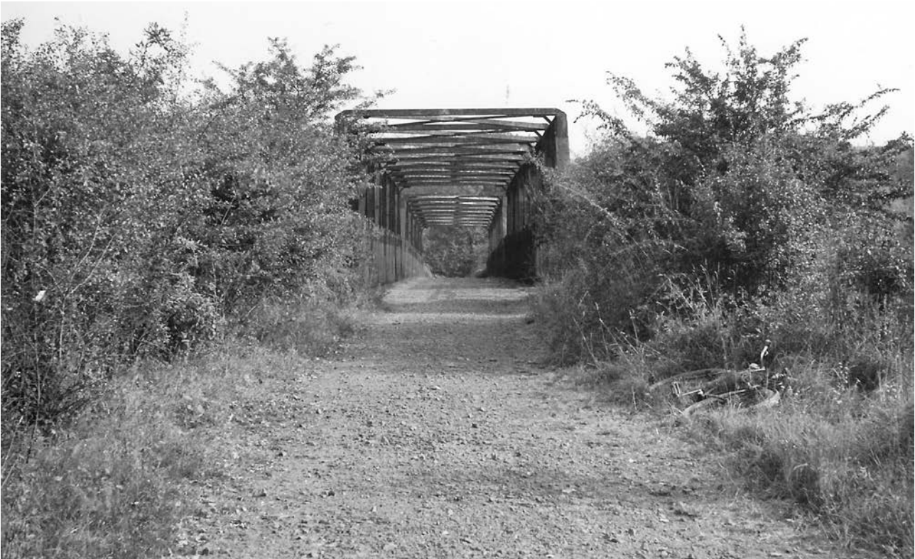
Abbildung 19: Ruhlsbrücke mit Blick auf den Fahrweg
