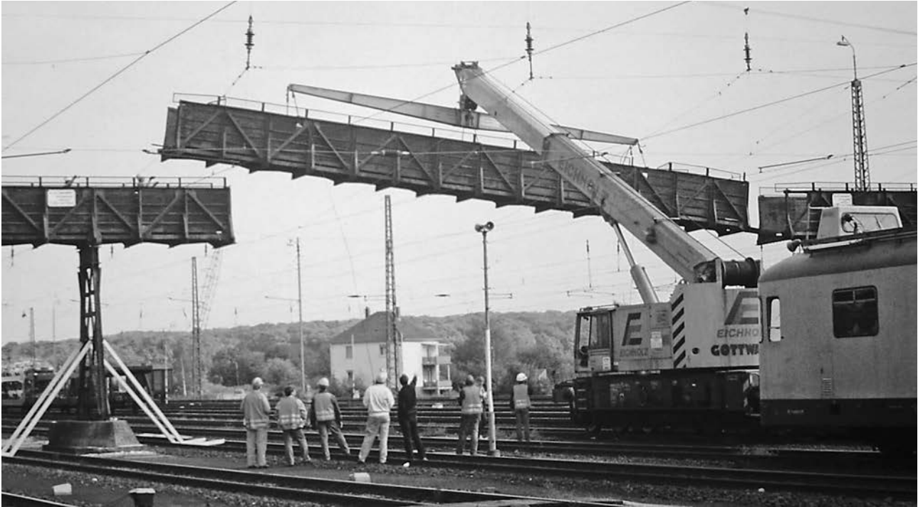
Abbildung 15: Rückbau des Steges
