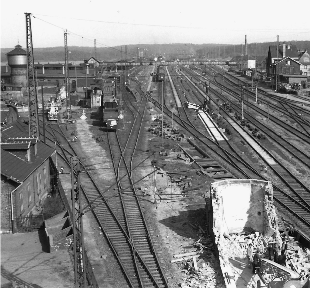
Abbildung 23: Blick aus dem neuen Stellwerk
