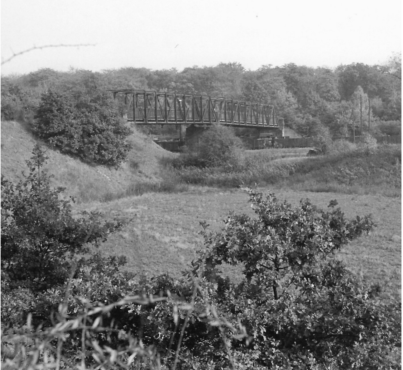
Abbildung 20: Eisenbahnfahrzeuge unter der Brücke
