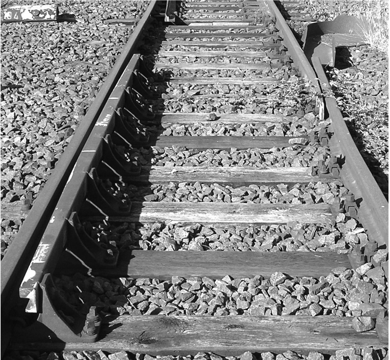
Abbildung 22: Büsingbremse
